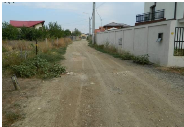
Gropi cu dezagregarea structurii materialului din strat
