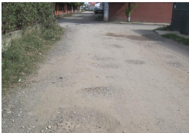
Gropi cu dezagregarea structurii materialului din strat
